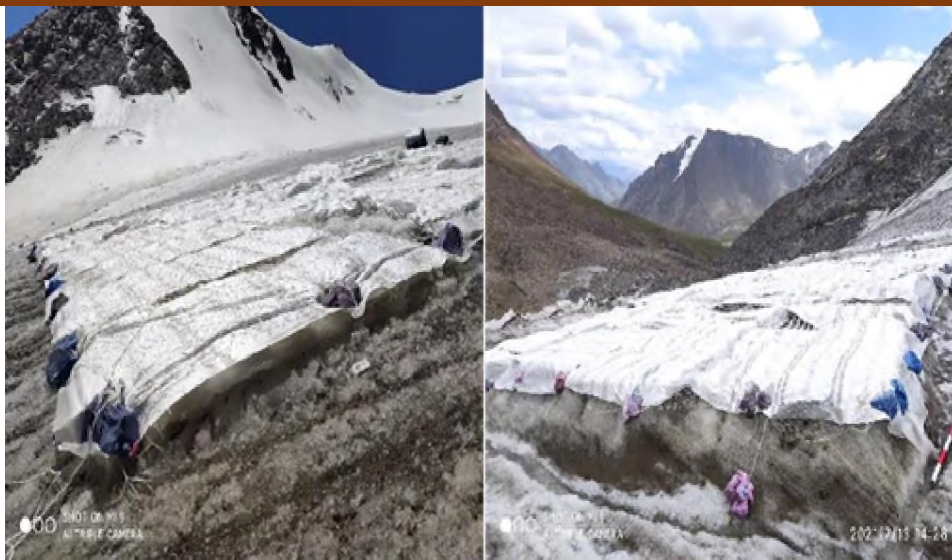
Расми 6 – Усули пӯшиши сунъӣ барои коҳиш додани обшавии пирияхҳо
