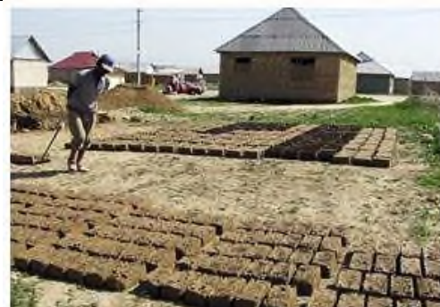
Рисунок 2. Формирование и высушивание сырцового кирпича
