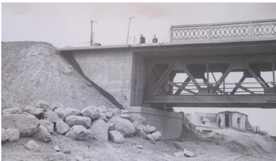
Расми 9 – Тахтасанги оҳанубетонӣ ва пояи канории пул
